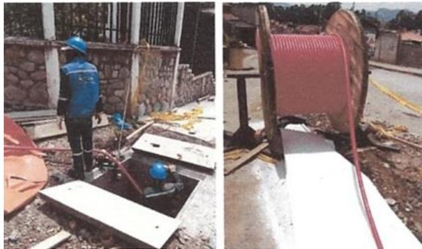
*Figura 1. Soterramiento de la red de MV*
