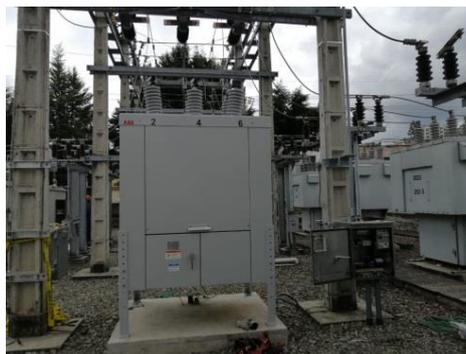
Figura 10. Acople de barra subestación Nro. 5
